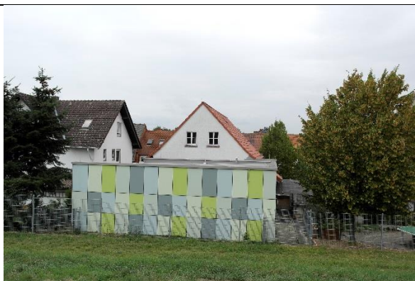
Foto 7: Anbau an Hauptgebäude 2
