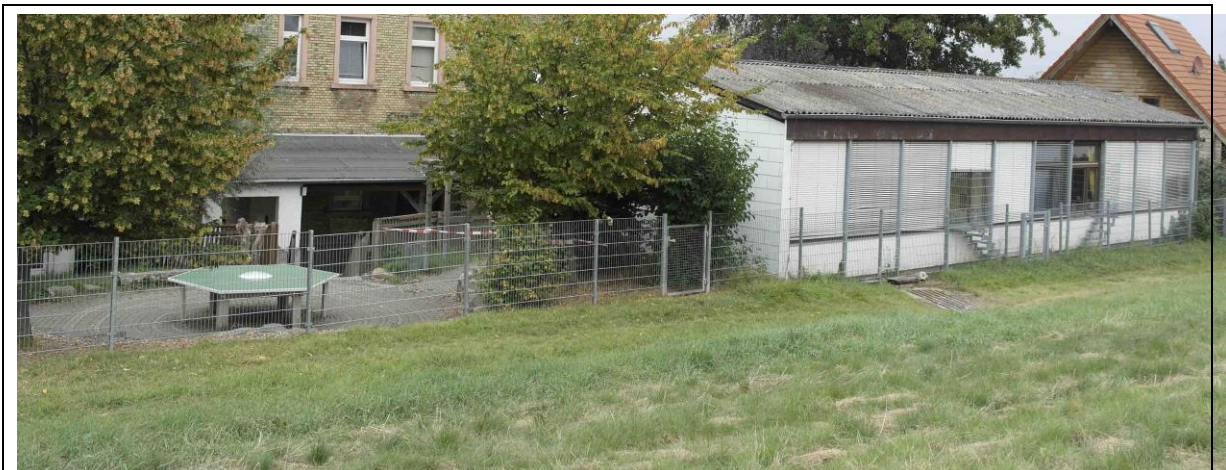
Foto 14: Schulerweiterungsfläche, südlicher Abschnitt Geltungsbereich
