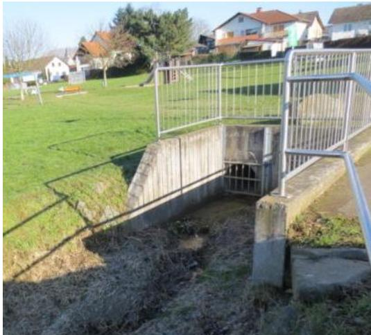
Der Rollgraben verlief ehemals im Flurstück 314/1. Inzwischen wird die Flächenentwässerung des Ortes in Kanälen gefasst, die im Bereich der westlichen Geltungsbereichsecke an die Oberfläche treten. Von dort aus führt der Rollgraben noch heute das Wasser der Nidda zu.
