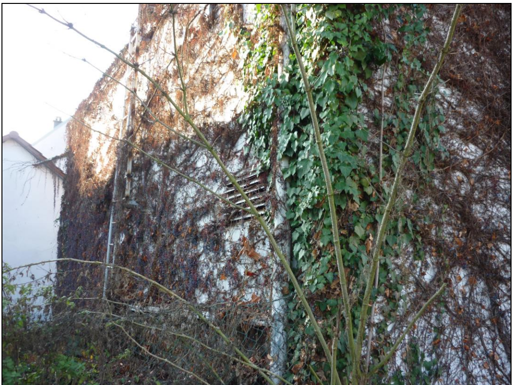
Abb. 8: Hauswand am Haingrabenweg, im Süden angrenzend an das Planungsgebiet
